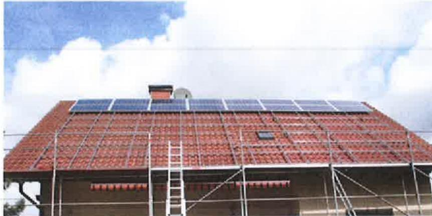
**2-disposition des panneaux photovoltaïques sur les rails**
