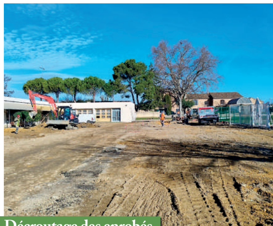
Décroulage des enrobés
