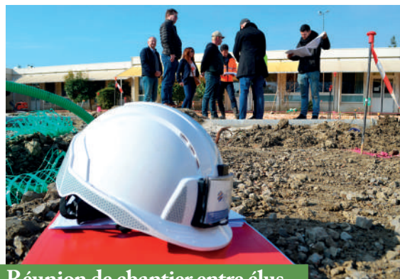
Réunion de chantier entre élus - maîtrise d'ouvrage - entreprises chaque mercredi matin
