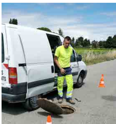
Remplacement d'un tampon de visite en fonte rue Marie Curie.
